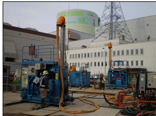
泊発電所での工事例（元請：鹿島建設）
