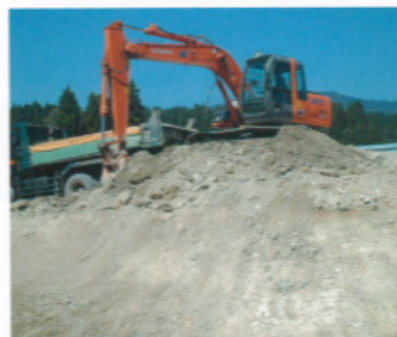
固化処理土 (コーン崩壊・材費5日) 800kN/m 2 以上
