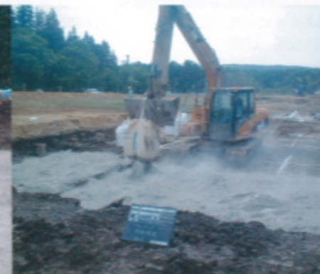
公園造成工事・地盤改良 (コーン崩壊・材費3日) 400kN/m 2 以上 固化材の混合はバックホウ (攪拌羽根・アタッチメント) 使用。
