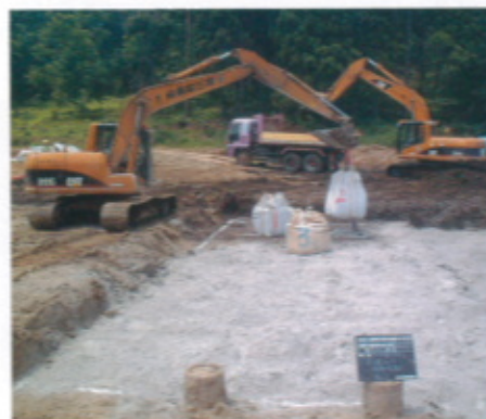
公園造成工事・地盤改良 (コーン崩壊・材費3日) 400kN/m 2 以上 固化材の混合はバックホウ (攪拌羽根・アタッチメント) 使用。
