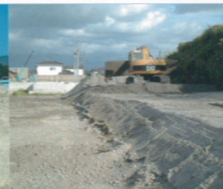
固化処理土の有効活用 / 路床、路盤改良材。
