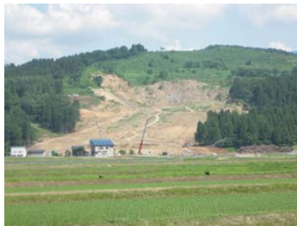
写真8. 地滑り応急対策工事完了
