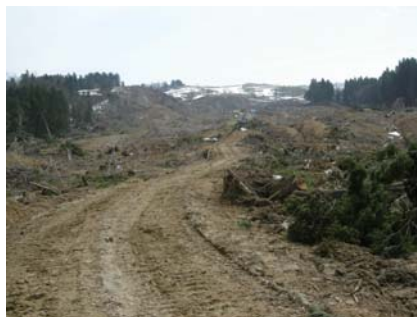
写真7. 仮設道路完成
