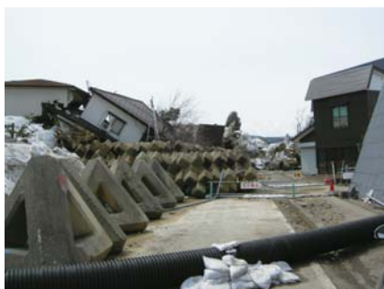
写真5. 住宅損壊状況
